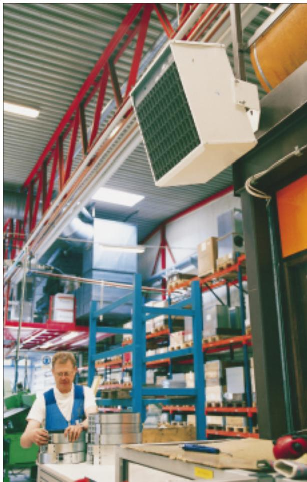
Тепловентиляторы семейства Panther могут эксплуатироваться как в самых тяжелых производственных условиях, так и там, где более всего важны требования по низкому уровню шума.
