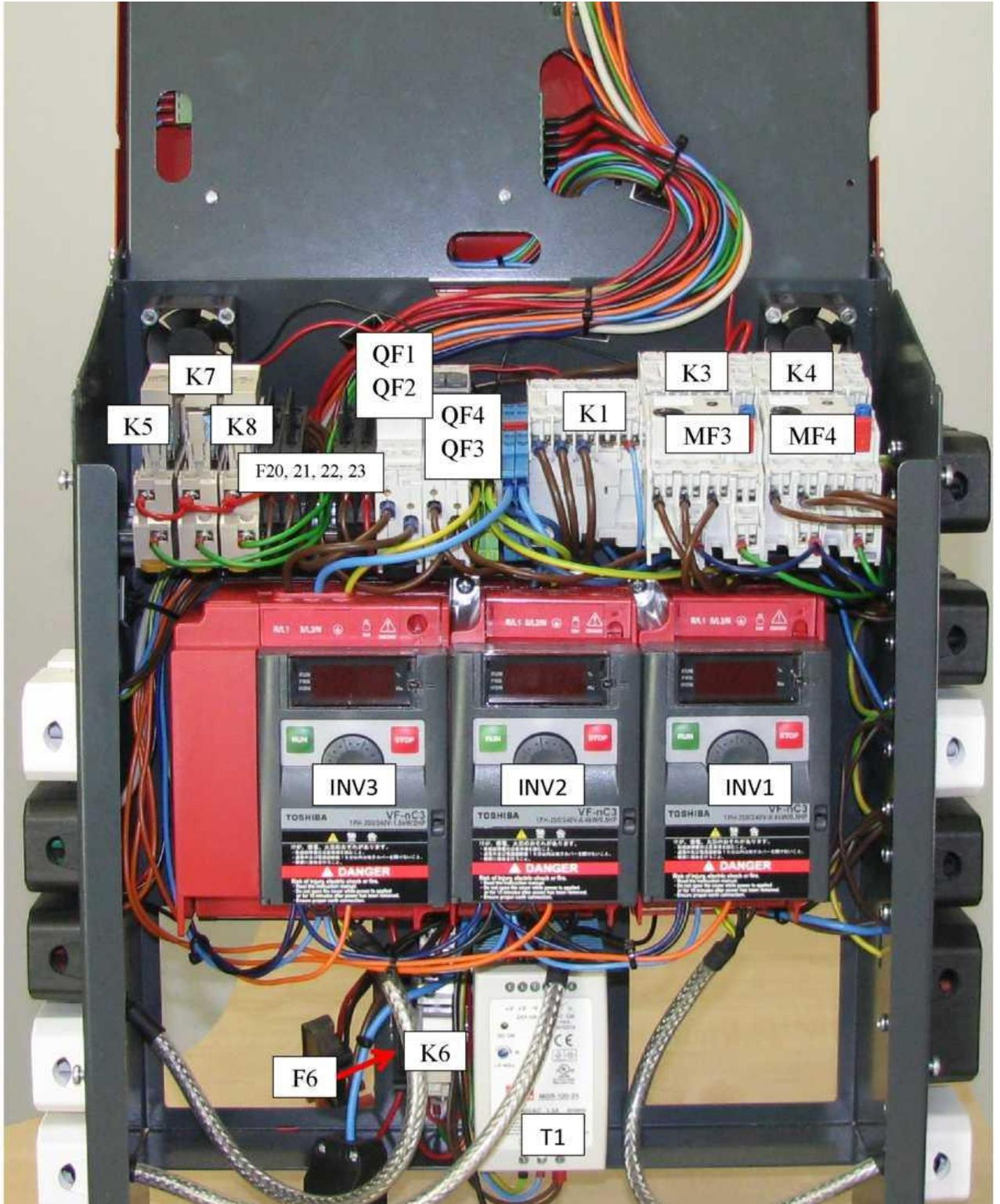
Рисунок 42. Блок управления PV1000
