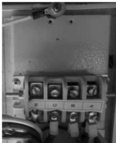
Рис.5 Подключение котла к электросети.
