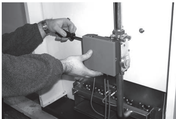
рис. 7 - Открутите два винта крепления блока управления
