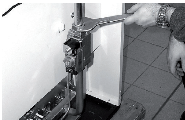
рис. 9 - Открутите гайку крепления газового клапана
