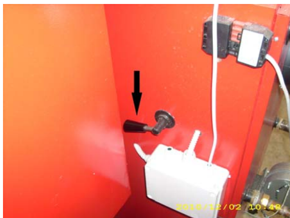
Рисунок 7. Положение ручки клапана «РАБОТА»
