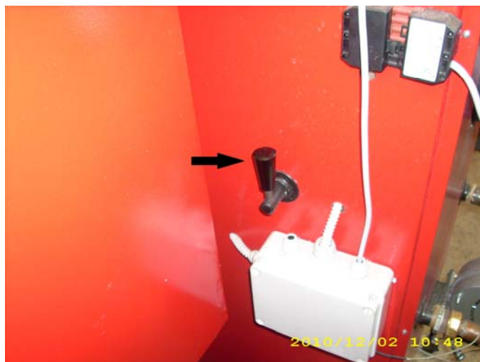
Рисунок 9. Положение ручки клапана «ПОДЖИГ»
